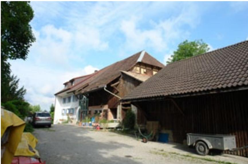
Bauernhaus an der Hirschengasse 1: Wirtschaftstrakt mit Krüppelwalmdach und Giebelwand in Riegelkonstruktion. Wohnbereich in massiver Bauweise mit Giebeldach mit hell gestrichener glatter Dachuntersicht.
