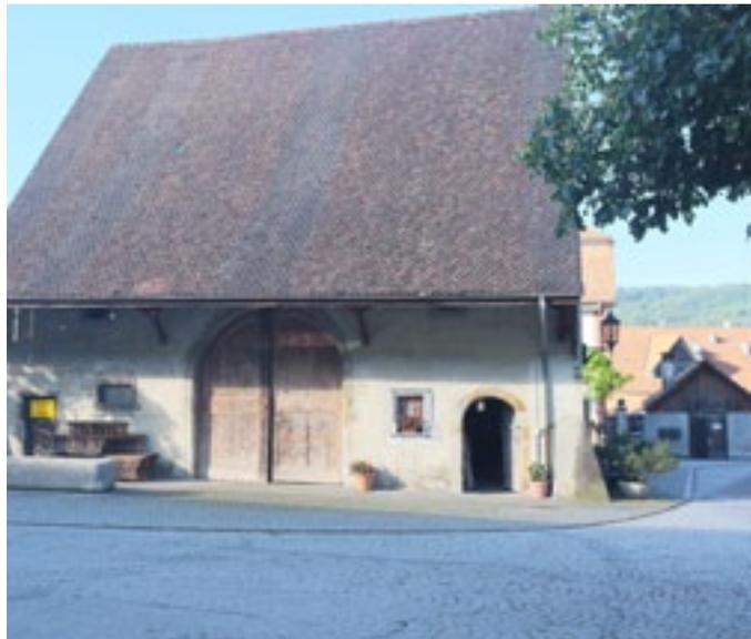
Ehemalige Zehntenscheune: bündiger Dachabschluss aus Biberschwanzziegeln über verputzter Giebelwand, im Bereich Vordach mit Schürze in Holz-brettern verblendet.
