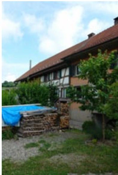
Scheune an der Kretzgasse: flächenbündig ausgefachter Riegelbau mit strukturellen Lüftungsöffnungen.
