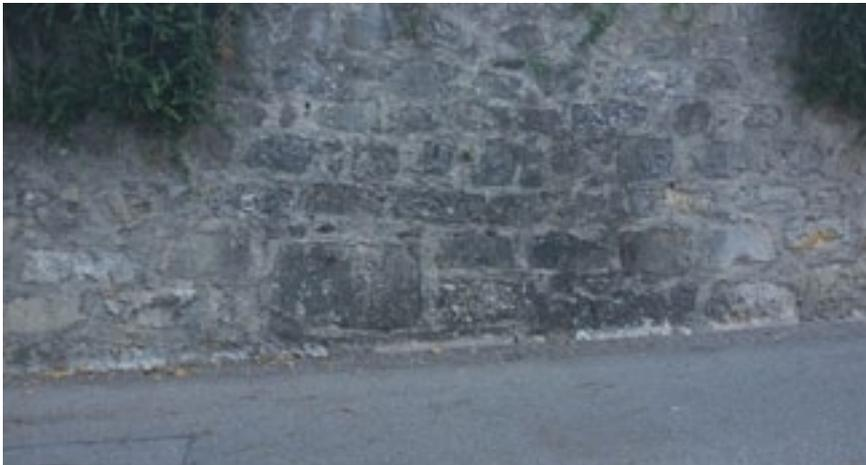
Stützmauer bei der Pfarrkirche: Bruchsteinmauerwerk mit leichtem Anzug und breit verputzten Fugen.
