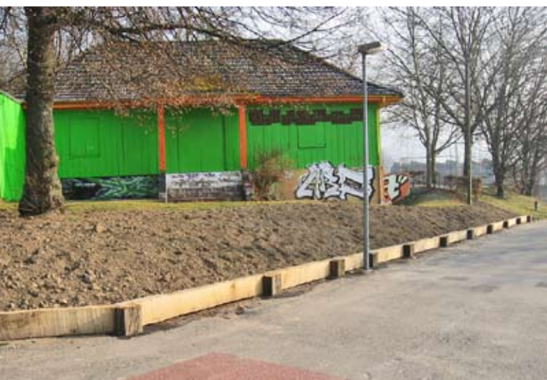
Bauarbeiten beim Jugendhaus durch das Bauamt Obersiggenthal
