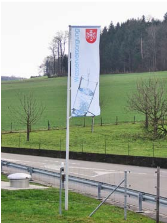
Neue Fahne der Wasserversorgung bei der Quellfassung Hertenstein.
