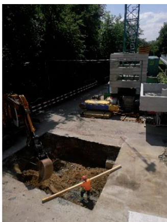
Pressgrube für den grabenlosen Anschluss der neuen Kanalisation an die Innengarderoben
