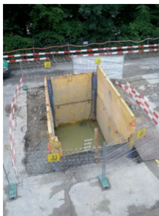
Pressgrube für den grabenlosen Anschluss der neuen Kanalisation an die Innengarderoben
