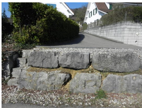
Höhenunterschied zwischen Tiefgaragenzufahrt und Tannenweg
