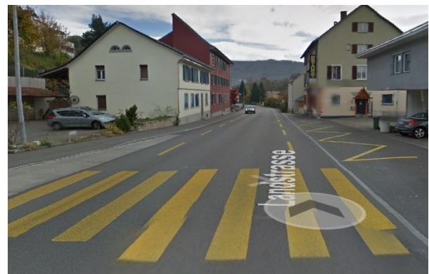
Abbildung 9: Radstreifen auf der Landstrasse
