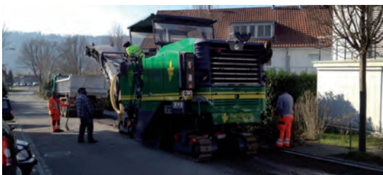
An der Brühlstrasse wurde der defekte Belag abgefräst und durch ein Provisorium ersetzt.
