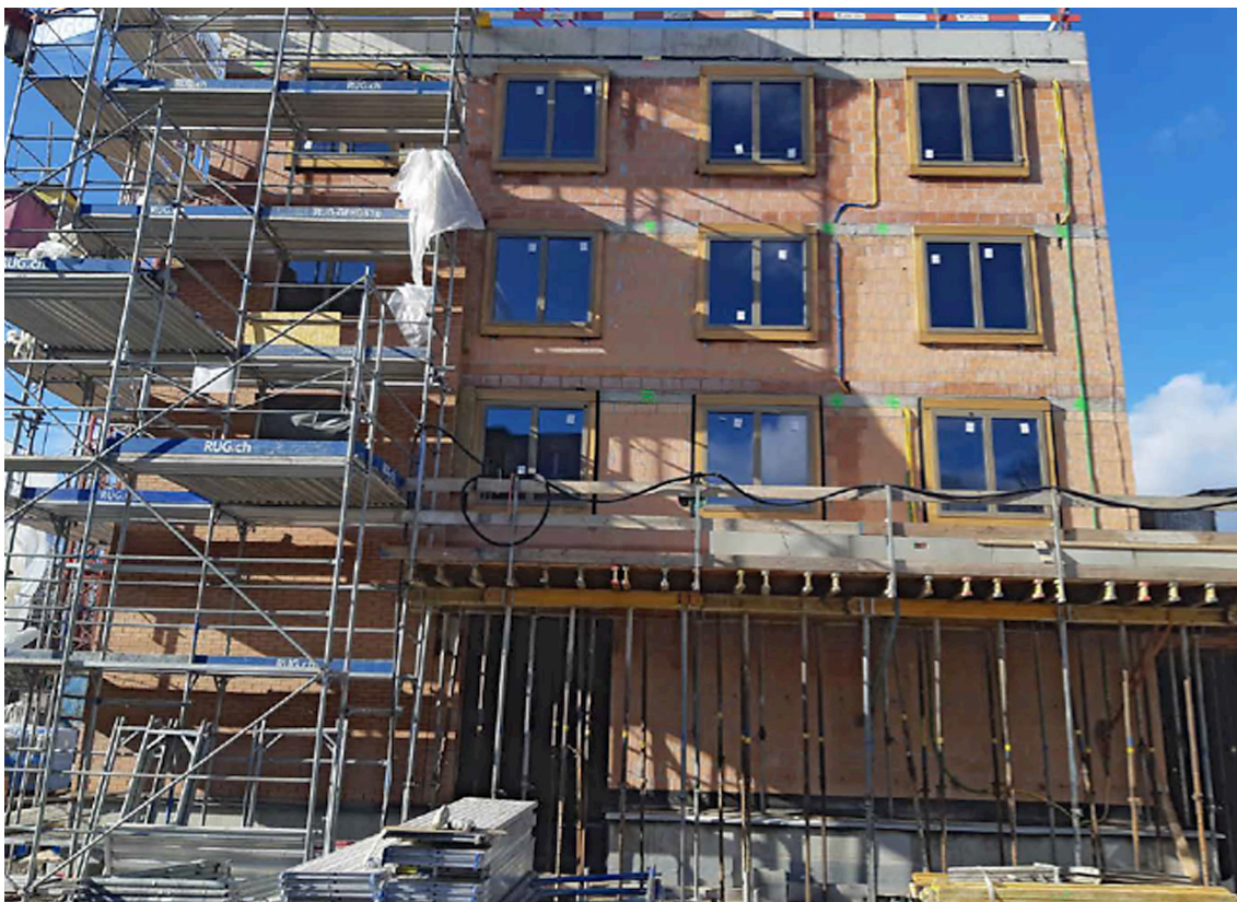
Foto: Stoos Architekten AG, Brugg / Anbau Ost Haus Limmat
