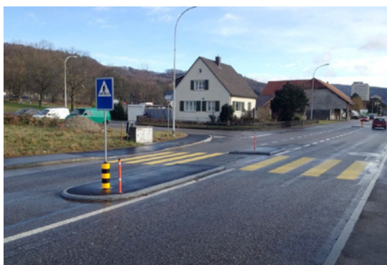
Knoten Landstrasse-Schützenstrasse neu mit Fussgängerschutzinsel und Mittelzone
