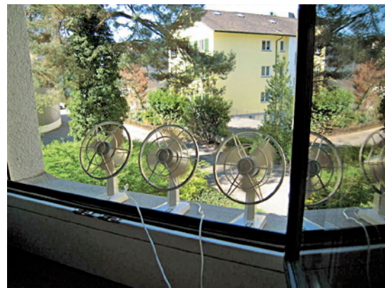
Notfallmässige Kühlung im Serverraum!
