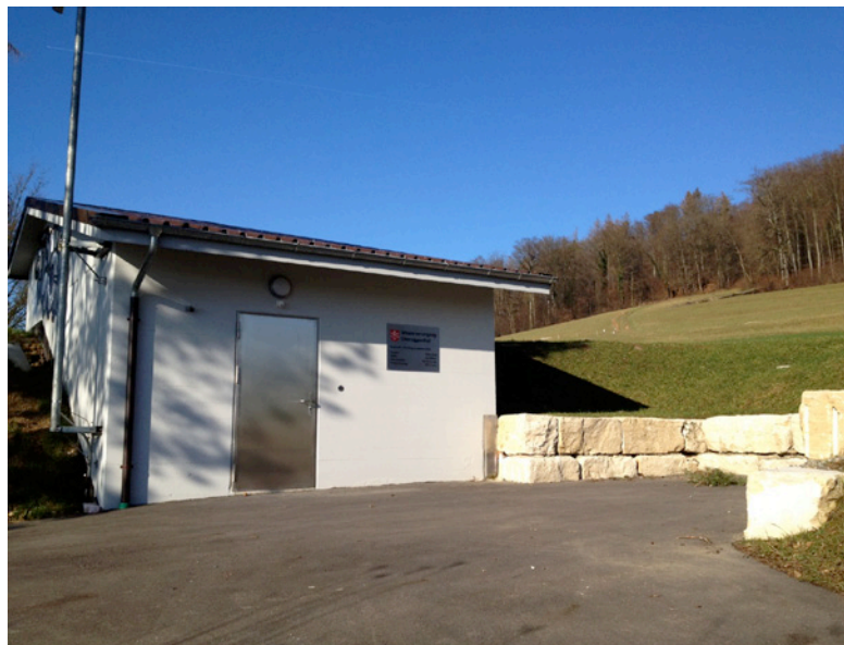
Der Zugang zum Schieberhaus beim umgebauten Reservoir Grüt
