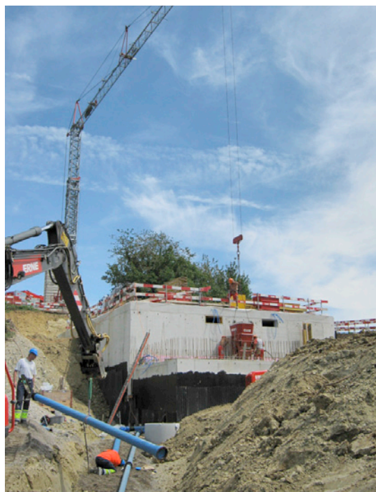
Baustelle Reservoir Kirchdorf im August 2009
