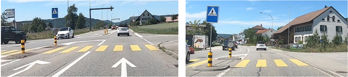
Abbildung 22 Streifen über 2 Fahrspuren (links), Insel ohne Randabschluss (rechts)
