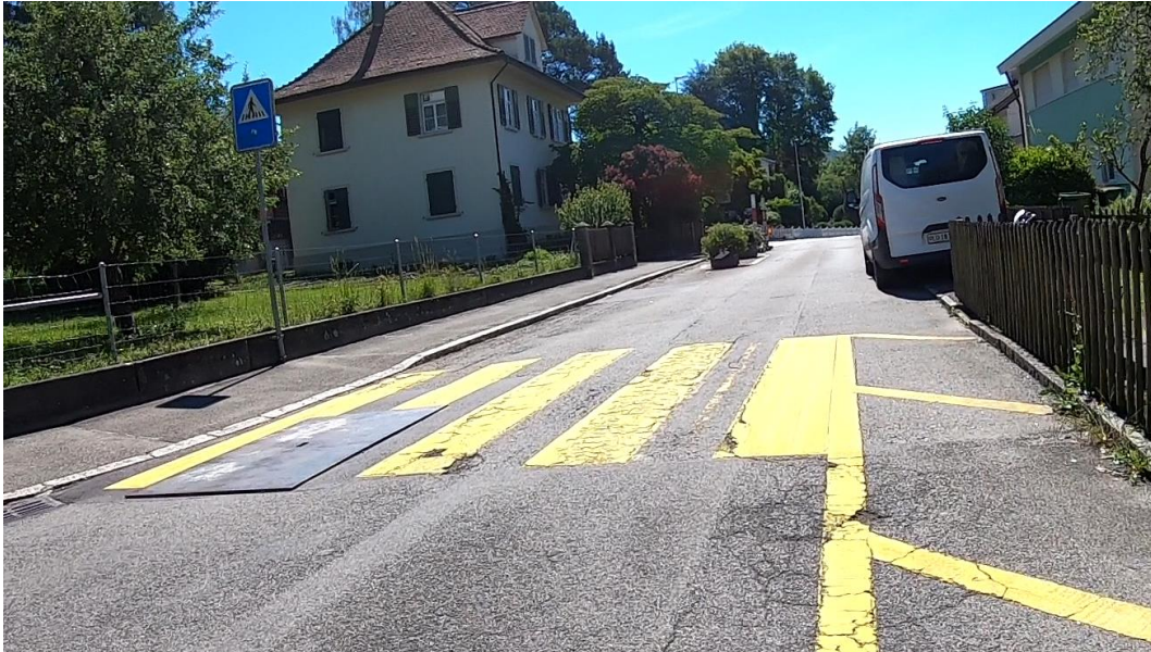
Abbildung 43 Fussgängerstreifen vor dem Kindergarten; mit ungeschütztem Annäherungsbereich (rechts)
