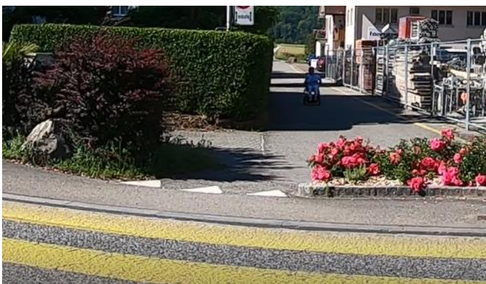
Abbildung 23 Nicht konforme Markierung einer Wartelinie
