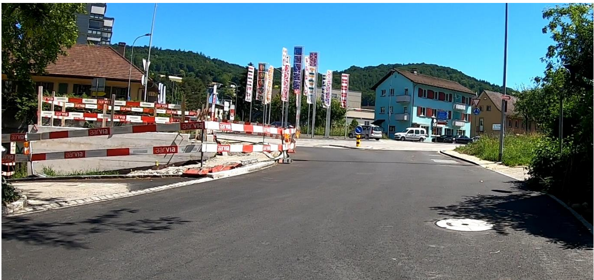
Abbildung 36 Ungünstiger Querungswinkel und schlechte Sichtverhältnisse rechts
