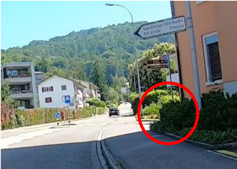
Abbildung 49 Sichtbehinderung auf das Trottoir durch Bepflanzung beim Schulhaus Bächlimatt
