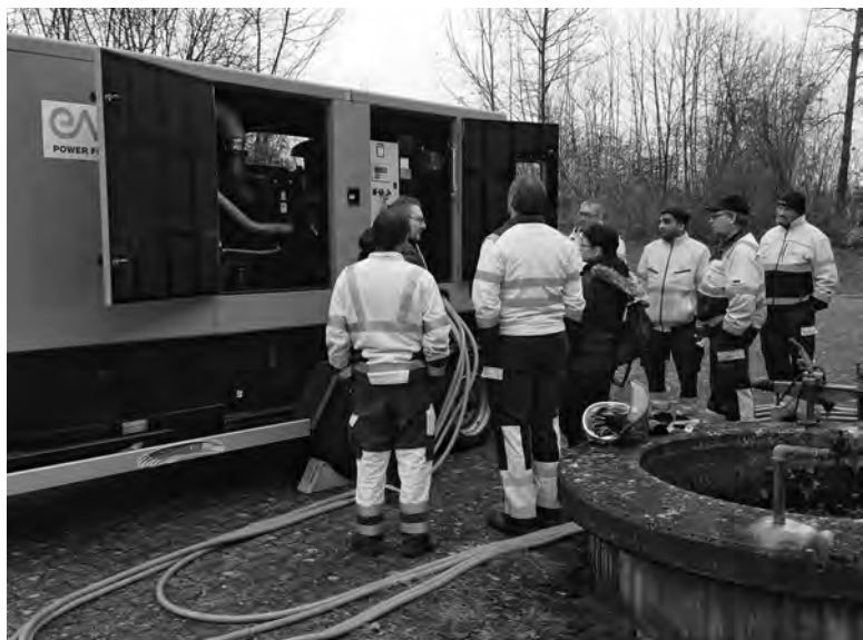
Vertreter/-innen des Gemeinderates, des Kantons und der Wasserversorgung lassen sich die Notstromanlage des EWW erklären
