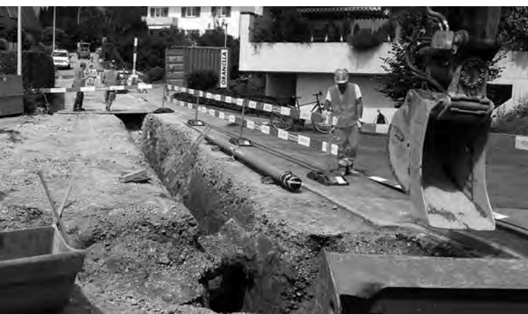
Bauarbeiten an der Wiedackerstrasse, Kirchdorf im Sommer 2016
