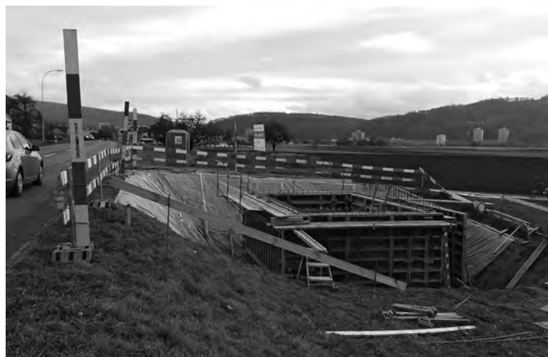
Übergabestation im Bau
